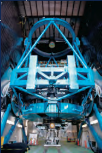
建物内部のすばる望遠鏡本体。主鏡の口径は約8.2m。上部の中心に見えるのが主焦点だ。これを含め全部で4つの焦点を持ち、おののに備えられた独自の観測装置や、それらを効果的に用いるための自動交換システムなどがある
